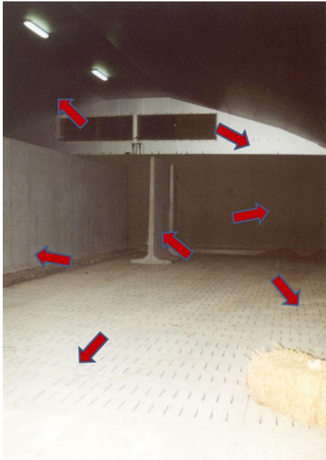
Figure 2 - Emplacements d'un stockage où la présence de résidus de CIPC peut être aisément détectée
