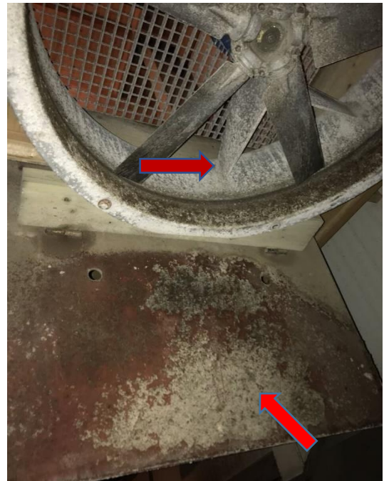
Figure 3 – Ventilateur et volet anti-retour en bois présentant des dépôts visibles de CIPC
